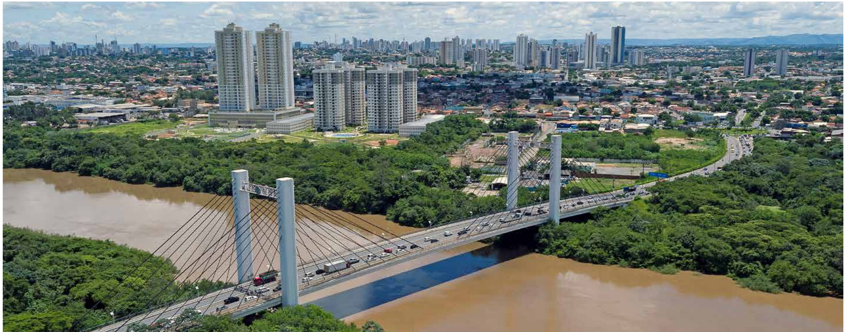
Vista da Ponte Sérgio Motta, entre as cidades de Várzea Grande e Cuiabá
